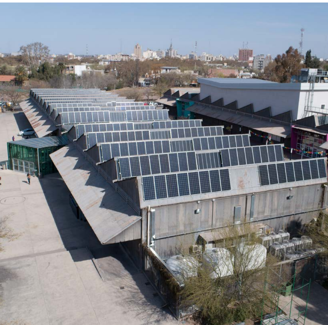
El centro cultural de la ciudad de Mendoza y su Nave Cultural, con más de 200 paneles solares instalados.
